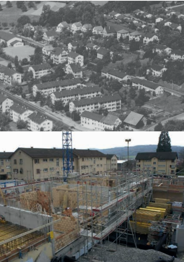
OBERENGSTRINGEN IN DEN 60ER JAHREN UND AKTUELL DIE BAUSTELLE DER ERSTEN ETAPPE
